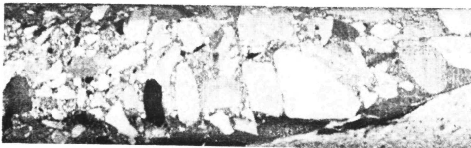
Obr. 3. Doskovité úlomky usporiadané kolmo na priebeh trhliny. Vrt ZB-2.
